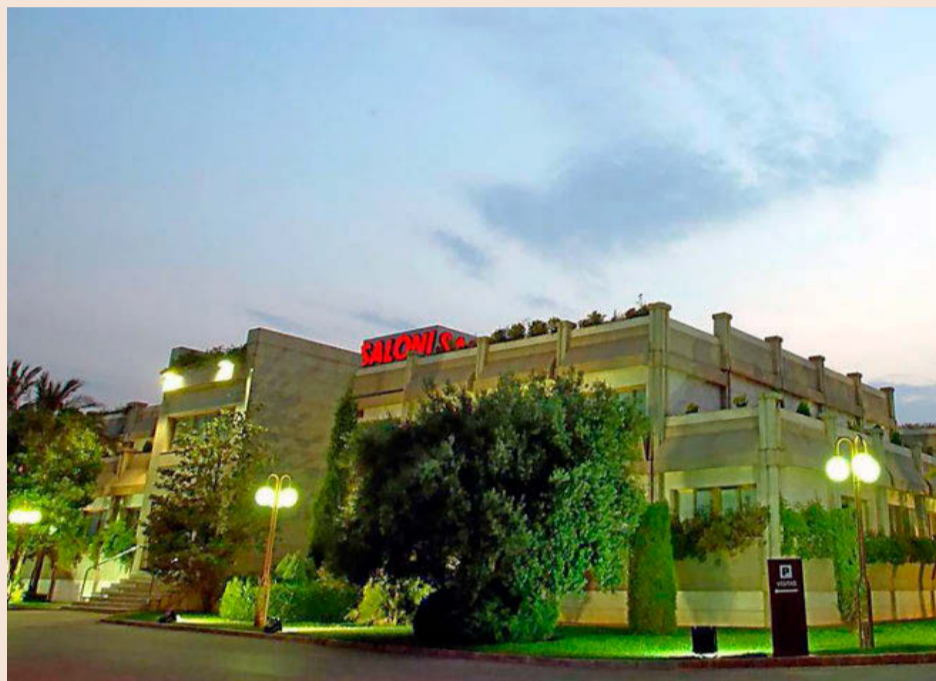
Las instalaciones de Saloni en San Juan de Moró (Castellón).
